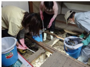
小栗栖宮山学区 床下からの泥出し作業の様子
